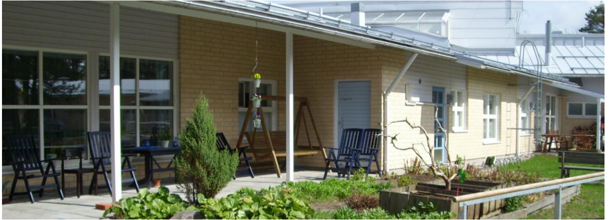
Kuva 6. Asuntoja lähellä sijaitsevat terassit olivat mieluisia paikkoja.
