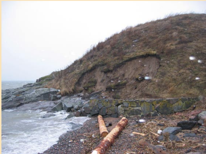
Kuvat 5 ja 6. Vedenpinnan nousun tammikuussa 2005 aiheuttamia tuhoja Suomenlinnassa. Vasemmalla: Länsi-Mustasaaren tykkipatteri, korkean veden ja aallokon aiheuttama tukimuurin ja hiekkavallin sortuma (kuva: Heikki Lahdenmäki, Suomenlinnan hoitokunta). Oikealla: Pikku-Mustasaaren rantamuuri, korkean veden ja aallokon aiheuttama eroosio (kuva: Heikki Lahdenmäki, Suomenlinnan hoitokunta).
