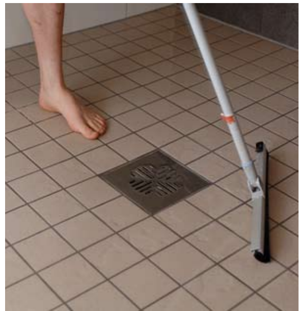
Kuva 6. Märkätilan lattian kuivaus on keskeinen osa asumisen aikaista kosteuden hallintaa /Juha Sarkkinen/.
