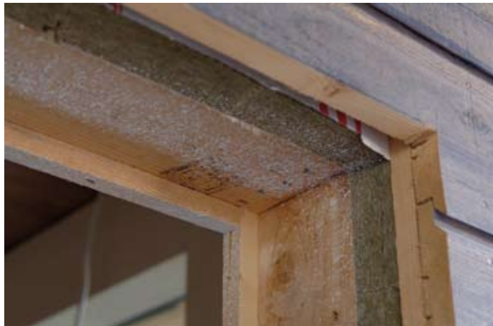
Kuva 14. Hyvin eristetty ulkovaippa on peruslähtökohta pientalon alhaiseen lämmöntarpeeseen. /Juha Sarkkinen/
