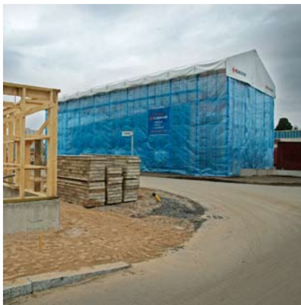
Kuva 10. Pientalon suojateltta parantaa merkittävästi kosteudenhallintaa työmaavaiheessa /Tapio Vanhatalo/.
