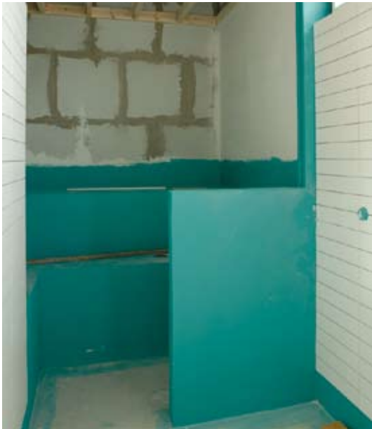
Kuva 5. Saunassa ja pesuhuoneessa tarvitaan huolella tehty vedeneristys /Juha Sarkkinen/.
