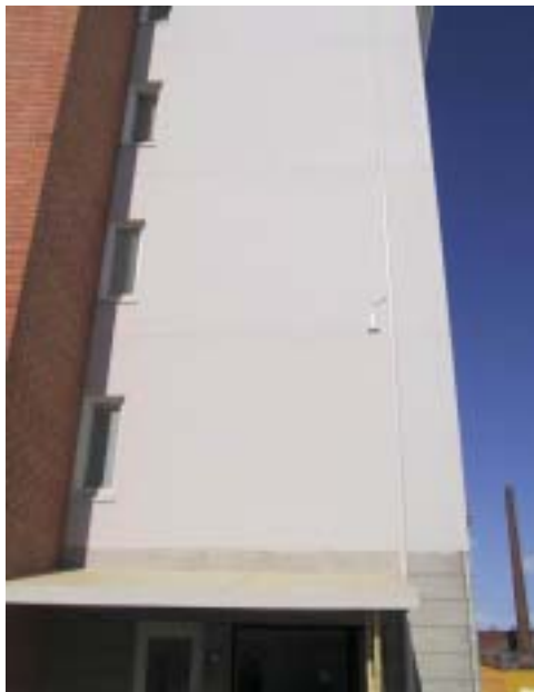
Kuva 4. Tukiasemapaikka ei aina vaadi mastorakennelmaa. Rakennuksen seinään kiinnitetty antennilaitte on huomaamaton tukiasemaratkaisu. Ratkaisua käytetään usein taajama-alueilla. Kuva Unibase Oy.
