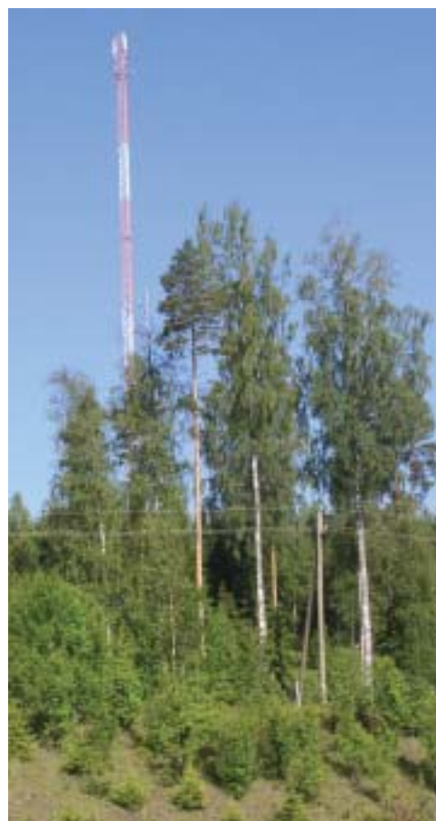
Kuva 2. Korkeiden sekä lähellä lentopaikkaa sijaitsevien mastojen punavalkoisen värityksen määrä Ilmailulaitos. Kuva Leena Lusa.
