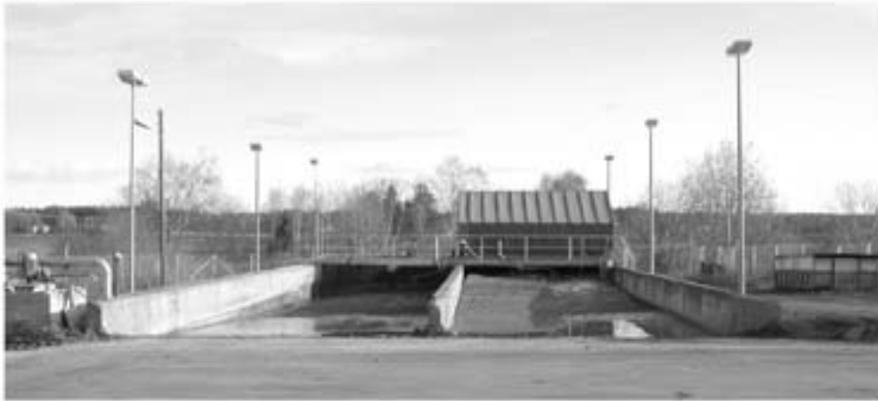
Kuva 6. Uitto- ja pesuvesien selkeytys.
