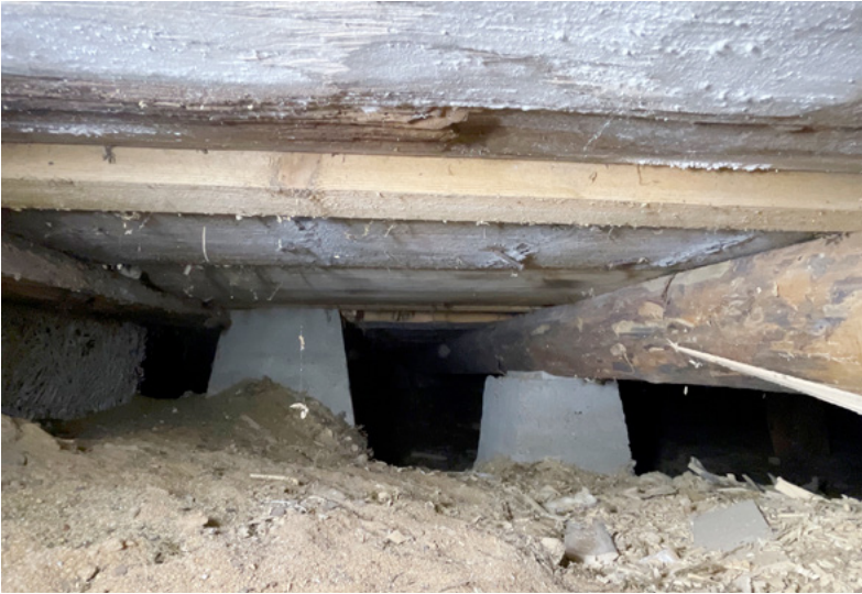
RYÖMINTÄTILA LATTIAN ALLA. KUVA JUSSI KALLIOKOSKI.
