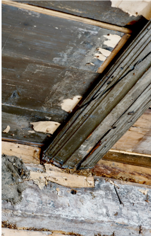
NURKKAKAMARIN TAITEKATON LINJAKKAASTI PROFILOITU KATTOKANNATIN. KUVA JUSSI KALLIOKOSKI.
