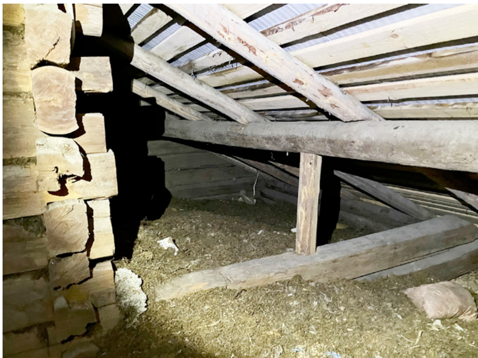
VÄLIPOHJAN HYVÄKUNTOISET SAMMALTÄYTYTEET OVAT NÄKYVISSÄ ULLAKOLLA. KUVA JUSSI KALLIOKOSKI.
