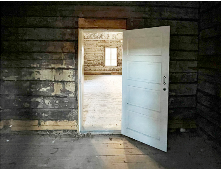
TALON OVET ON VAIHDETTU LUULTAVASTI SIIRRON YHTEYDESSÄ NELIPEILISIIN OVIIN, JOTKA OVAT VIELÄ HYVÄKUNTOISET, MUTTA POIKKEAVAT PEILIAOTUKSELTAAN JA MITTASUHEILTAAN ALUN PERIN TALOSSA OLLEISTA OVISTA. KUVA JUSSI KALLIOKOSKI.
