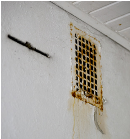
RAKENNUKSEN TALOTEKNIikka ON PURETTU PAINOVOIMAISTA POISTOILMAKANAVAA LU-KUUNOTTAMATTA. KUVA JUSSI KALLIOKOSKI.
