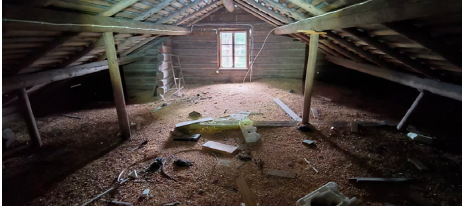
VÄLIPOHJAN ERISTEET ISONTUVAN PÄÄLLÄ. KUVA MATTI PALOSAARI.
