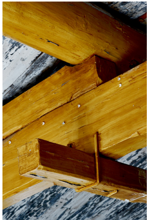
TUVAN VEISTOKSELLISET KATTORAKENTEET. KUVA JUSSI KALLIOKOSKI.
