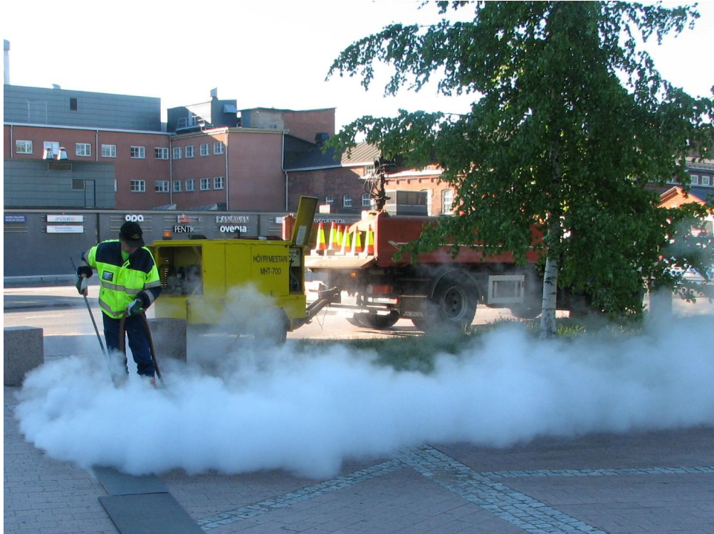
Kuva 4. Höyrykäsittelyssä käytettiin sulatustöihin suunniteltua laitteistoa.
