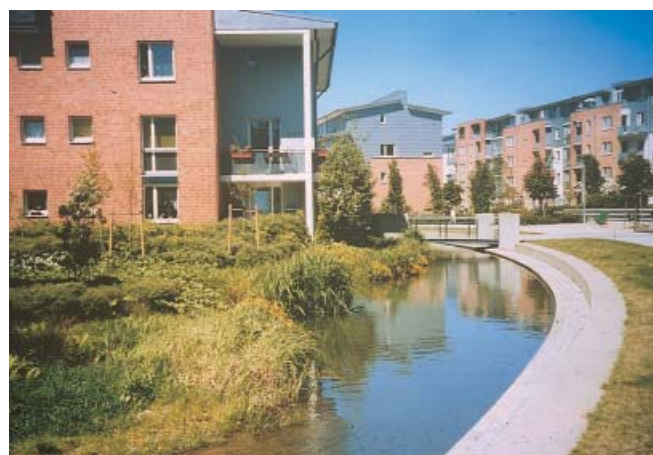
Kuva 10.2 Kadunvarsivesiä voidaan johtaa ja samalla puhdistaa matalissa ruohopeitteisissä painanteissa. Kuva Skotlannista, Dundee (yllä). Avoin sadevesijärjestelmä muodostaa samalla näyttävän vesiaiheen asutusalueelle. Kuva Hampurista, Travrennbahn (alla). Jukka Jormola
