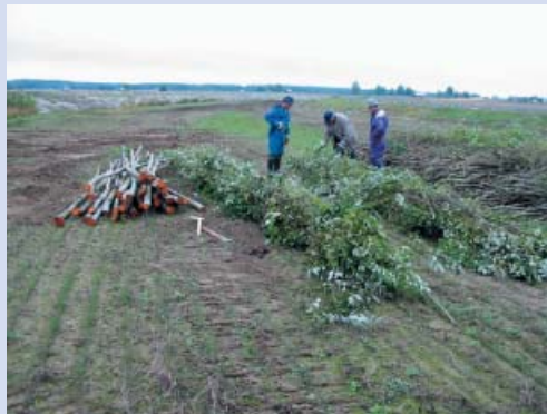
Risungin valmistusta (yllä) ja asennusta (alla) Kyrönjoella keväällä 2001.
