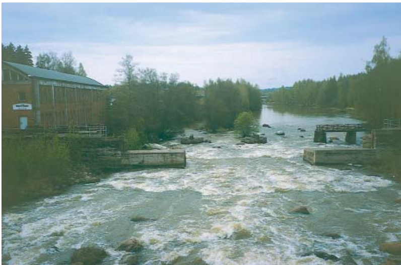
Kuva 7.1 Koskenkylänjoen alimmasta koskesta on purettu meritaimenen kulkua estänyt pato ja koski on kunnostettu kalataloudellisesti.
