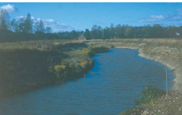
Kuva 4.3 Vasemmalla reunalla Tarpianjoen järjestelyhankkeen yhteydessä rakennettu tulvatasanne. Jukka Jormola
