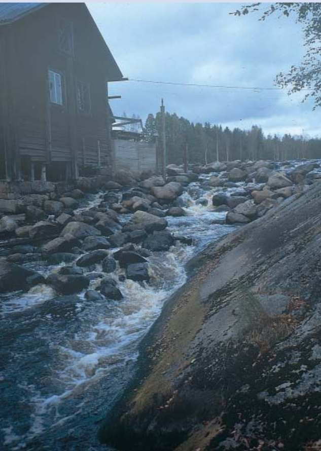
Aurejoen Poltinkosken myllypadon tilalle rakennettu tekokoski.
