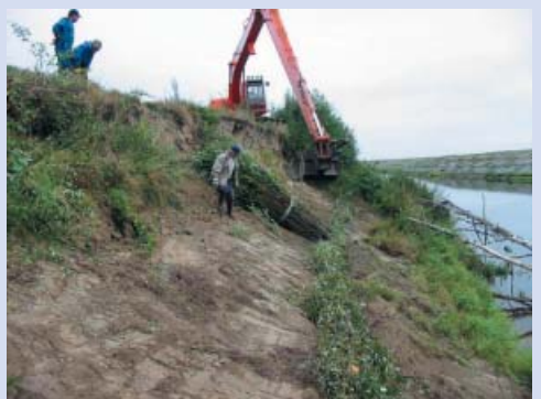
Kuva 8.4 Suisteita voidaan käyttää uoman ulkokaarten eroosiosuojauksessa. Samalla suiste monipuolistaa virtausta ja muodostaa suojapaikkoja eliöstölle. Kuva Itävallasta. Jukka Jormola
