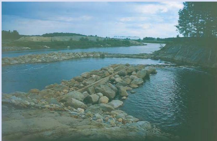
Malkakosken luonnonmukaisen pohjapadon patorakenteita.
