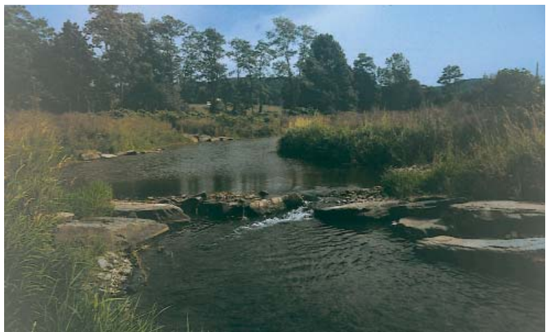
Kuva 7.2 Lohkokivistä rakennettu ns. Rosgenin pohjapato USA:ssa. Taustalla suisteita. Jukka Jormola
