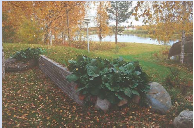
Pudasjärven tulvasuojeluhankkeessa penkereet sijoitettiin mahdollisimman lähelle rakennuksia, jolloin ranta jää tulva-alueeksi. Jukka Jormola
