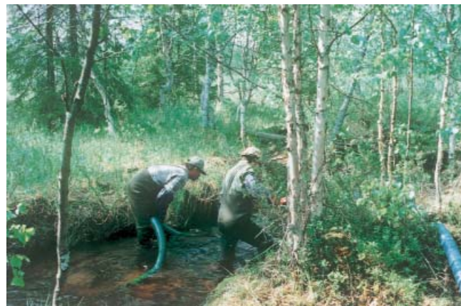
Kuva 8.6 Ejektoritoimisen imuruoppauskaluston käyttöä.
