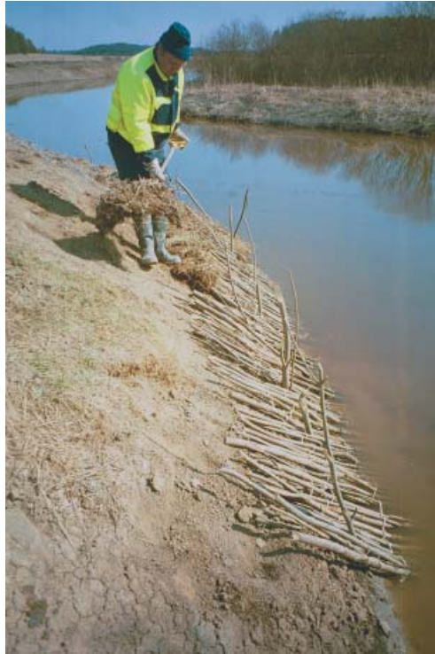
Kuva 8.5 Pajumaton asennusta Tarpianjoella. Lasse Sampakoski
