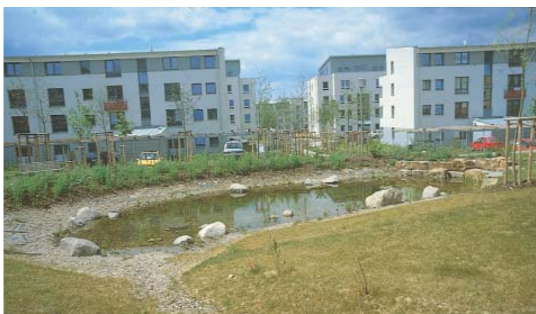
Kuva 10.1 Hannoverin Kronsbergissä on toteutettu laajamittainen hulevesien imeytys- ja viivytyjärjestelmä, jossa hulevesiä imeytetään katujen varsilla ja piha-alueilla. Jukka Jormola
