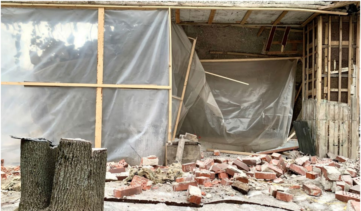
Kuva 17. Suojaukseen käytettävää kalvomuovia purkutyömaalla. Kuva: Annika Johansson.
