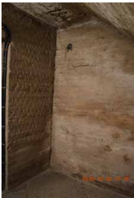
Kadunpuoleisen portaikon alapuolen valettu seinä ulkopuolelta. Betoniseinä on tehty tartuntoja rappausta varten. Kuva Teijo Laaksonen.
