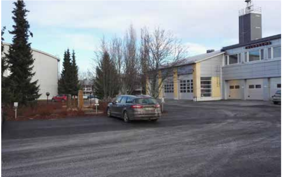
Paloasema vihittiin käyttöön vuonna 1963. Se tuli entisen elokuvateatterin paikalle joen rantaan. Taustalla näkyvä kaarevakattoinen pienkerrostalo – Nousevan Kuuhun talo – valmistui vuonna 1993. Puiset liikerakennukset purettiin rakennuksen pohjoispuolelta 1990-luvun alussa. Kuva Liisukka Oksa.
