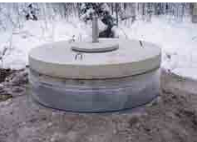
Kuva 76. Esimerkki moreenissa olevan lähteen yläpuolelle rakennetusta kaivosta. Lähteestä on jatkuva ylivuotoa, joka on johdettu kaivon takaa lähtevään ojaan. Kuvassa näkyvät hyvin kaivon ympärille asennetut routaeristeet. (Kuva: Pertti Virtanen)
