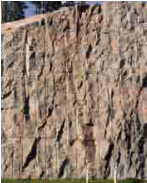
Kuva 21. Hyvin ehjä, harvarakoinen (rakoluku RLI) graniittikallio. Rakoilu on vähäistä ja kivi on hyvin tiivistä. Kun kivilajikontaktejakaan ei esiinny, pohjaveden saantiin näyttäisi olevan kuvan perusteella huonot mahdollisuudet. Ehjältäkin näyttävästä kalliosta on kuitenkin mahdollista saada pohjavettä vesipainehalkaisun avulla yhden talouden vedenhankintaa varten. Kuivia porakaivoja tai porakaivoja, joista ei saada riittävästi pohjavettä on muutama prosentti kaikista tehdyistä porakaivoista. Mahdollisuudet veden saantiin ovat kallioselänten reunamilla yleensä paremmat kuin sen päällä.
