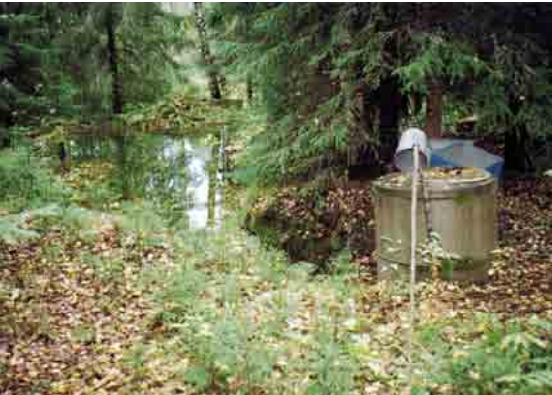
Kuva 108. Lähteeseen virheellisesti rakennettu rengaskaivo. Lähteen ylivuodosta muodostuu lammikko, joka on suoraan yhteydessä lähteeseen ja sitä kautta epäpuhtaudet voivat päästä kaivoveteen. Kaivo tulisi rakentaa lähteen läheisyyteen piirroksessa 8 esitetyllä tavalla. (Kuva: Toivo Lapinlampi)
