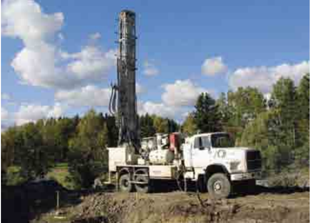
Kuva 119. Auton alustalla kuljetettavan porauskaluston pitää päästä porattavaan kohteeseen. (Kuva: Jouni Lehtonen)
