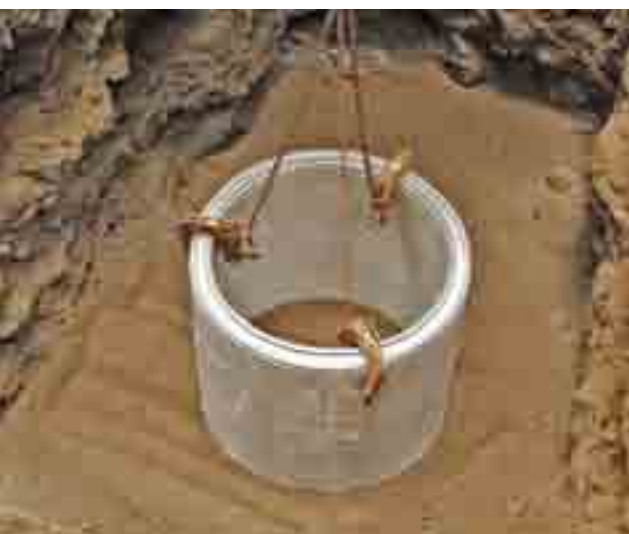
Kuva 75. Rengaskaivon rakentaminen tutkimusten perusteella kuvissa 6, 7 ja 8 esitetylle paikalle. Tutkimusten kulku on esitetty kuvissa 42 ja 50–52. Maaperä on kivistä hiekkamoreenia. Tutkimusten mukaan pohjaveden pinta oli huhtikuussa 2007 noin 3,5 metrin syvyydellä maanpinnasta. Kaivanto pysyi kaivun aikana kuivana. Veden tulo kaivoon oli hidasta, mikä on tyypillistä kaivolle, jolla on pieni pohjaveden muodostumisalue. Veden saannin nopeuttamiseksi kaivoon tuotiin heti rakennustyön päätyttyä puhdasta vettä, jolla täytettiin hiekasta muodostettu vesipesä kaivon ympärillä. Kaivo täyttyi vedellä vähitellen ja syksyyn mennessä kaivossa oleva vesi oli pohjavettä, joka on tässä kaivossa laadultaan hyvää.
