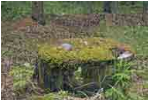
Kuva 113. Sammaleen peittämä rengaskaivo, jota ei ole huollettu vuosikausiin. Pintavesien kaivoon pääsyn estävää suojakerrosta tai tuuletusputkea ei ole rakennettu. Kaivon sijainti pihapiirin ulkopuolella on kuitenkin hyvä. Sammaleen alla voi olla puinen huoltoluukku, joka on todennäköisesti lahonnut ja kaivo on näin ollen hengenvaarallinen.
