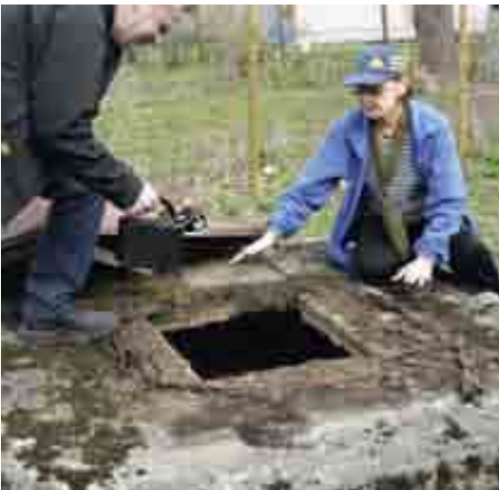
Kuva 115. Vanhan kivikehäkaivon kuntoa arvioidaan voimakkaan lampun avulla.
