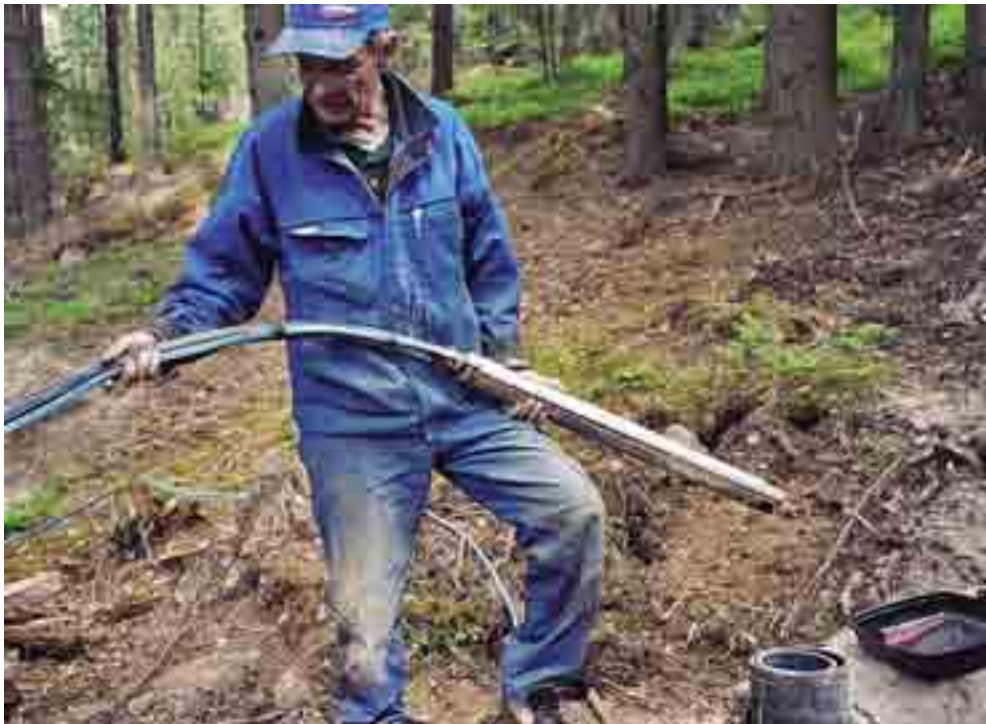
Kuva 138. Porakaivon huuhtelu- ja koepumppausta varten puhtaan porausreiän pohjalle asennetaan uppopumppu.
