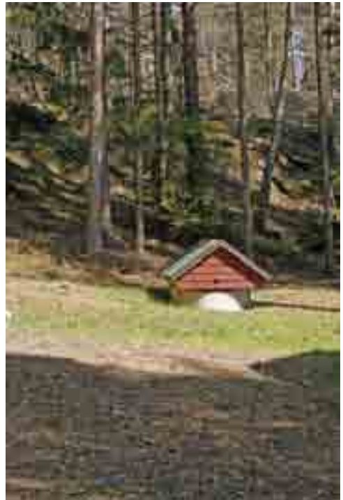
Kuva 96. Rengaskaivo kalliobelänteen reunamalla olevan, noin viisi metriä paksun rinteeseen yläosassa, missä maaperä on silttiä. Maaperä muuttuu rinnettä alaspäin siirryttyä saveksi. Kaivo on sijoitettu liian ylhäälle rinteeseen (piirros 6 ja kuva 35), minkä vuoksi kaivossa ei ole riittävästi vettä.
