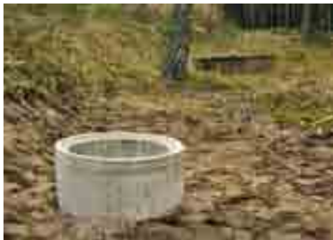
Kuva 94. Rengaskaivo reunamuodostumassa. Kaivosta on ajoittain ylivuotoa, joka on haluttu viemäröidä. Viemäröinti on tehty etualalla olevan jakokaivon kautta, josta vesi johdetaan lähellä olevaan lampeen (piirros IID). Kuva on rakennusvaiheesta, minkä vuoksi ylivuotokaivosta puuttuu vielä kansi.
