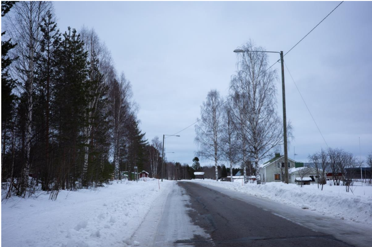
Kuva 44. Raanujärventie Kantomaanpään kohdalla 8.3.2024. Kuva: Vilppu Rantanen
