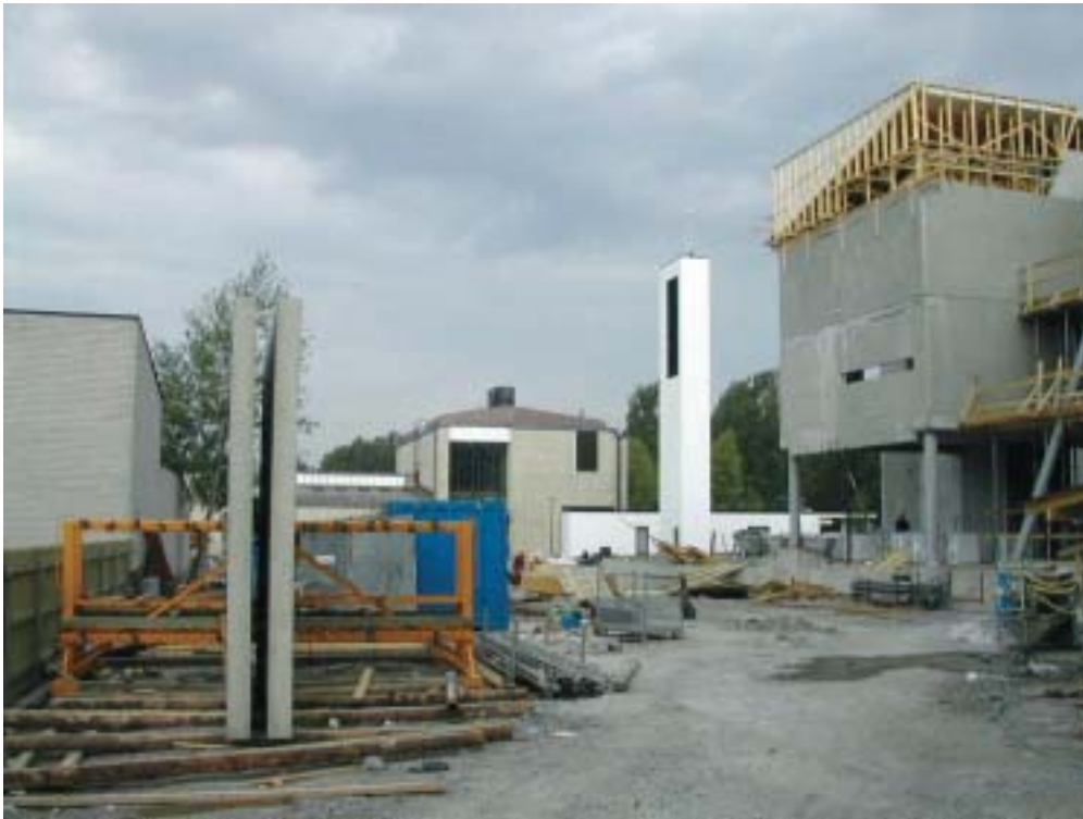
Korson kirkko ja LUMOn työmaa.
