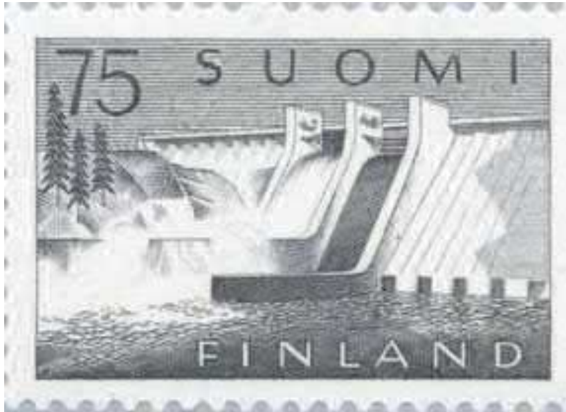
Kuva 6-12. Pyhäkosken voimalan postimerkki (1963). Voimala sijaitsee Oulujoessa Muhoksella ja on yksi Suomen suurimmista. Se avattiin vuonna 1951, Sen sähköteho on 122 MW ja putouskorkeus 32,4 m. Postimerkin on suunnitellut Olavi Vepsäläinen.
