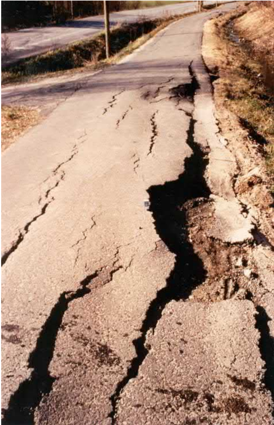
Kuva 7-19. Routavaurio. Haapaniemen paikallistie, kevyen liikenteen väylä, Jyväskylän mlk vuonna 1981. Kuva: Rismo Virpimaa. Liikenneviraston kuvakokoelma/Mobilia museo, Kangasala.
