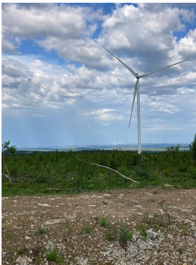
Kuva 2. Lumivaaran tuulipuisto Hyrynsalmella. Taustalla näkyvät Kivivaara-Peuravaara sekä Illevaaran voimala-alueet.
