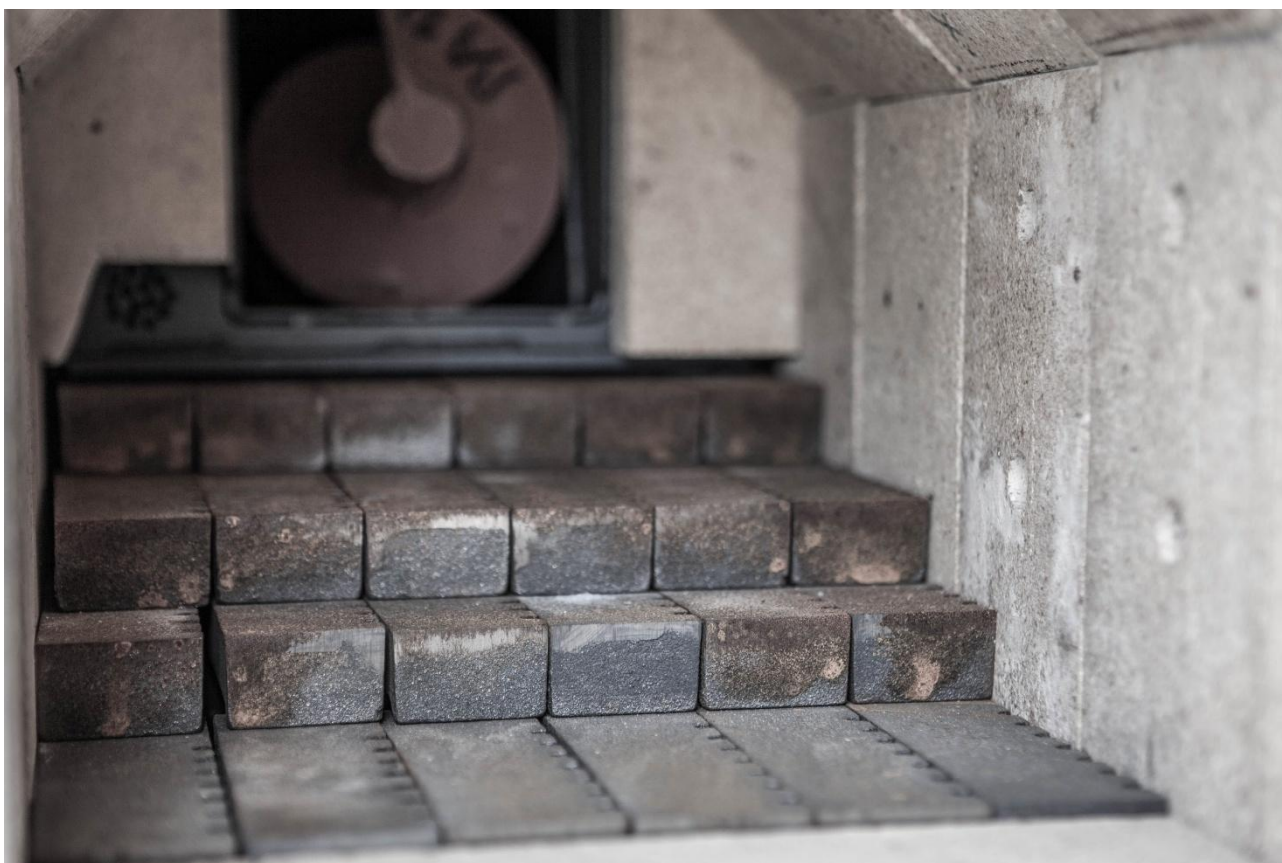
Kuva 3. Liikkuva porrasarina 240 kW kattilan palopäissä. (Kuva: Heatfactory Oy)
