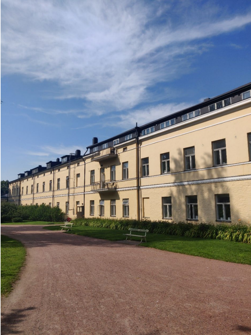
Picture 2: Lapinlahden Lähde, a place combining mental health and cultural facilities (Photo: Joonas Hassinen)
